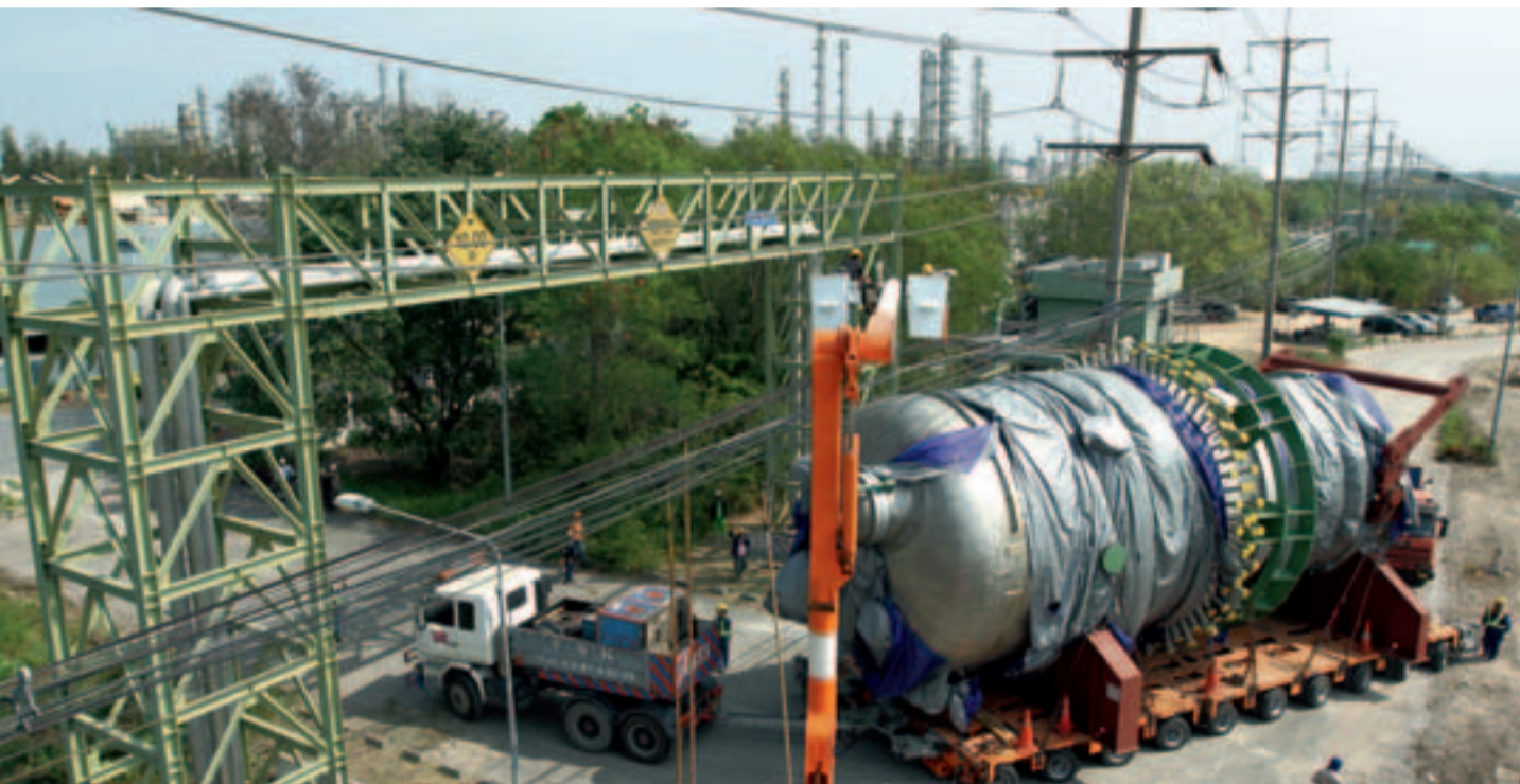
Ein 227 t schwerer Reaktor unterquert auf THP-Achslinien eine Stromleitung.
