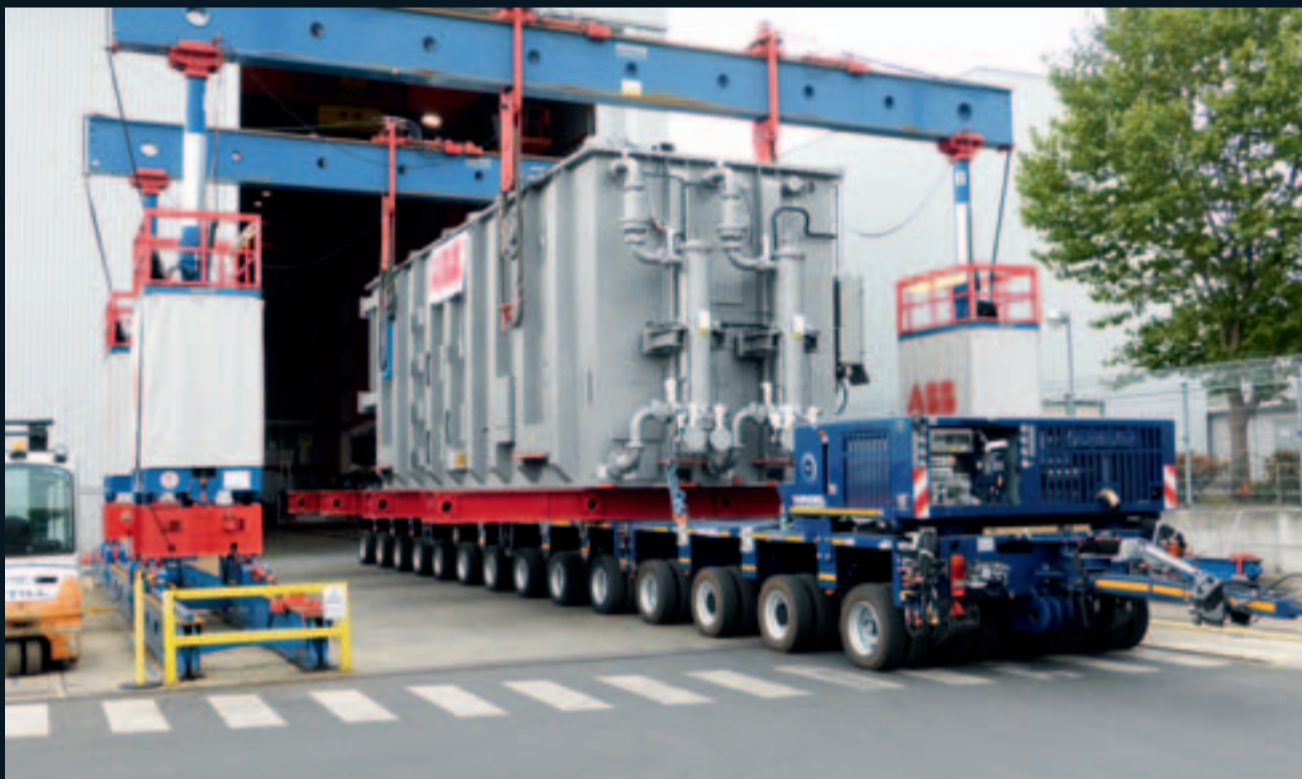
Laden des Transformators
