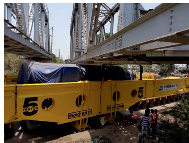
Ein schwieriges Unterfangen: Das Unterfahren zweier Eisenbahnbrücken
